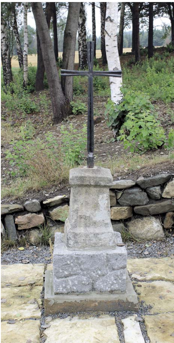
Foto po rekonstrukci: Olga Ondráčková 2015
